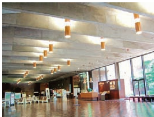
写真3 エントランスホールの照明設備
