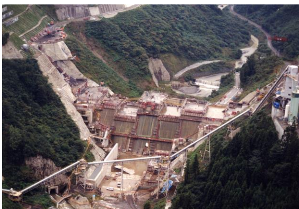
建設中の合角ダム(合角ダム管理事務所提供)
