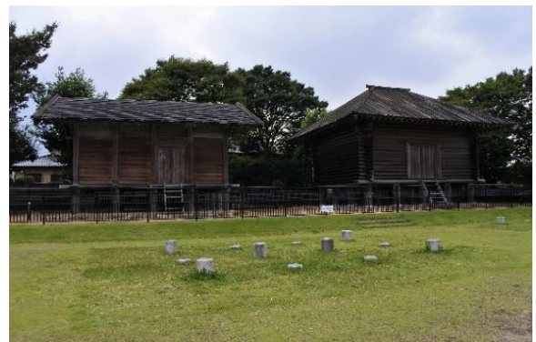
復元された正倉(深谷市・中宿遺跡)
