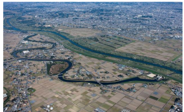
改修工事が実施された現在の荒川(荒川上流河川事務所提供)
