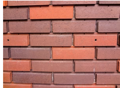
図2 打ち込みタイル 穴は釘止めの痕跡。
