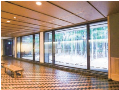
図1 水平連続窓 近代建築には構造壁がなくなり、大きな窓の設置が可能となりました。
