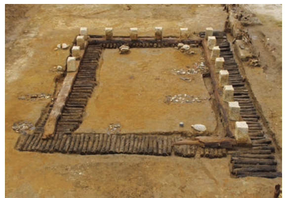
図3 建物の基礎にみる軟弱地盤対策
