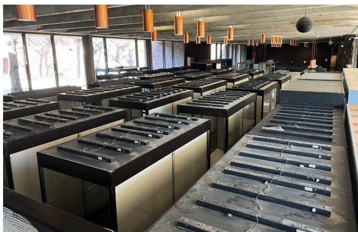
改修作業のため
