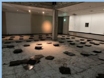
【#休館中のお仕事】どうなってるの? 大規模改修工事の様子
