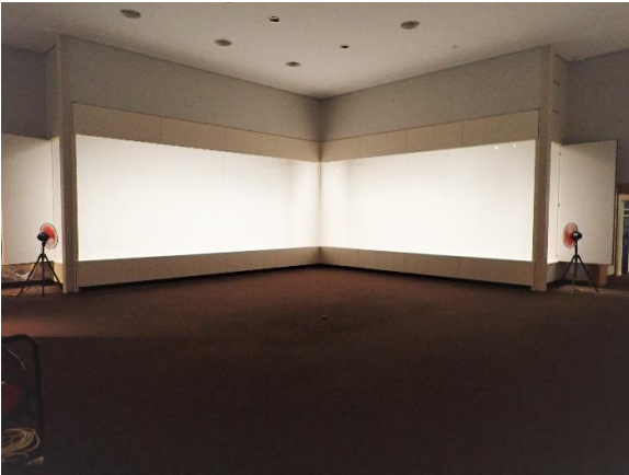
常設展示室第3室の新ウォールケース 施工後に風を送り、枯らしをしている。
